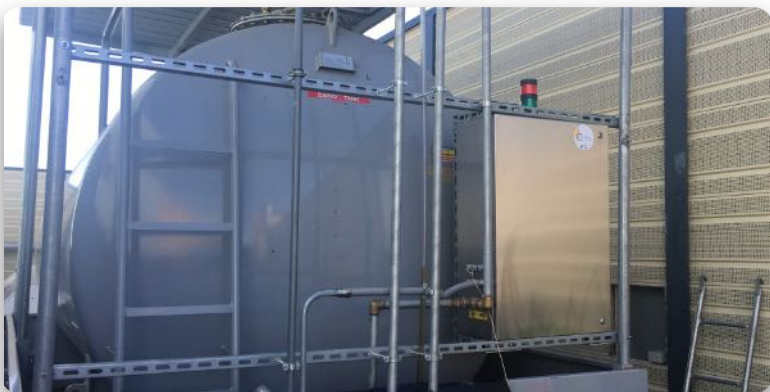
Installazione Diesel Defender 79 su cisterna RFI (Ferrovie dello Stato)
